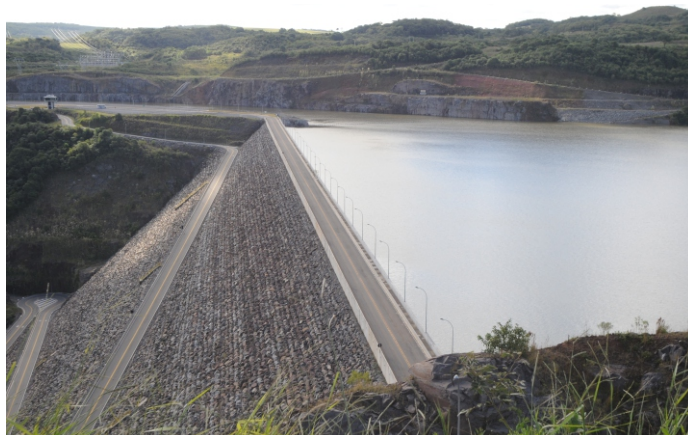
Barragem e demais estruturas da Usina são monitoradas permanentemente por mais de 100 instrumentos
